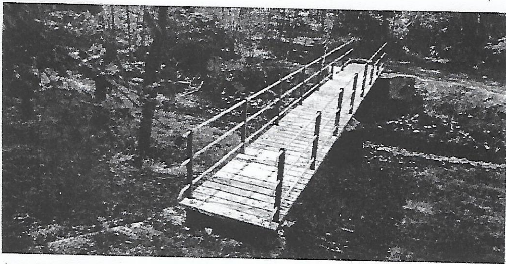
▲ Caslino al Piano: ricostruzione ponte
